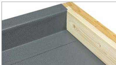
31. Det ene parapetskjørtet monteres inn til hjørnet. Forsveis og hovedsveis på takflaten.
