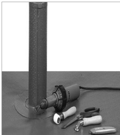
30. Ferdig inntekket rør
